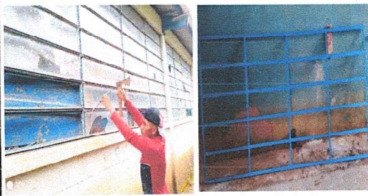
Foto 4: cambiando estructura de vidrios y vidrios de ventana de aula.
