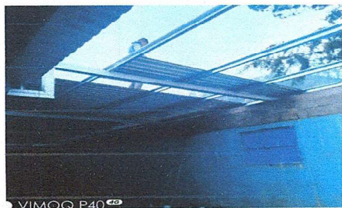
Foto 1: Cambiando de estructura de techo y techo del salon que se utiliza como aulas. Cambiando estructura de madera a costanera y laminas estructurales.
