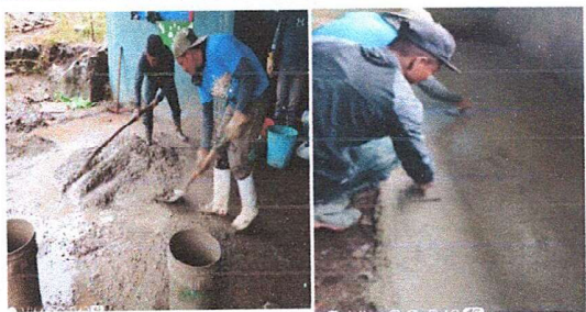
Foto 3: reparando piso de concreto que estaba en mal estado.
