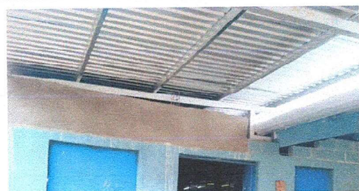
Foto 5: Remodelando la instalacion de estructura de laminas y laminas troqueladas.
